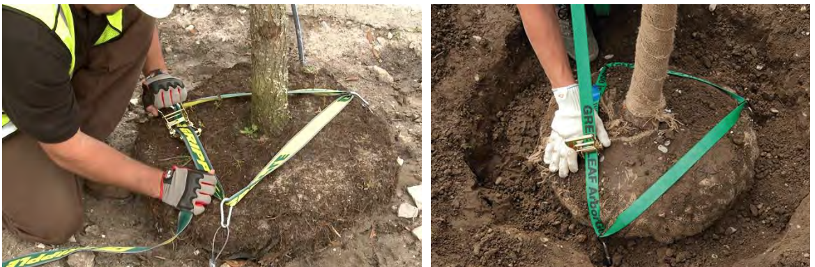
Ancoratges subterranis amb sistema d'eslingues i trinquet
