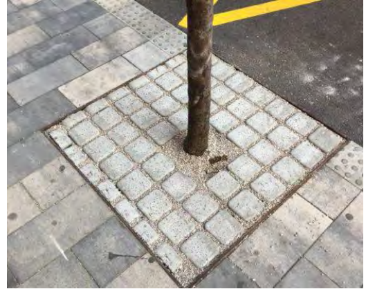
Reixa metàl·lica i sistema de llambordes prefabricades per tapar escocells
