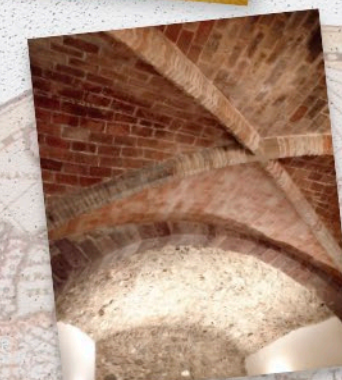
Sostre de la sala Gòtica
